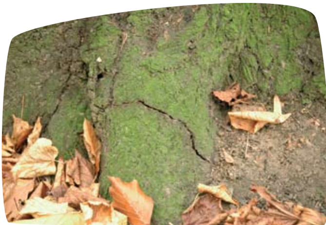
Een dwarsscheur, zoals op deze wortelaanzet, is een ernstig defect.
